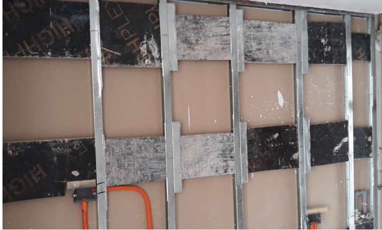
Refuerzo de tabiquería
